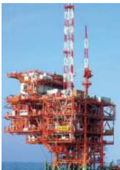
Slika 1.5 Čelična platforma rešetkaste konstrukcije oslonjena na morsko dno (izvor: http://www.ina.hr/ )
